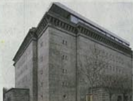
Betonhaus. Der Umbau des Bunkers in der Reinhardtstraße von Realarchitektur.
