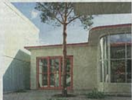
Verkehrsschutz. Die Tankstelle in der Bülowstraße von Broer Flachsbarth Schultz.
